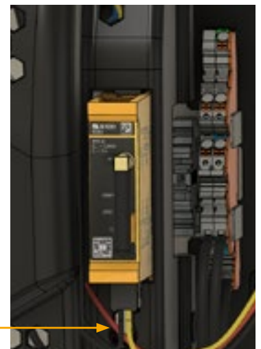
Abbildung 27: Anschluss Datenkabel des Deckels
